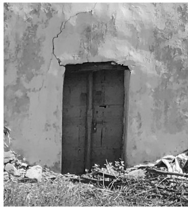
Simple door / entrance
